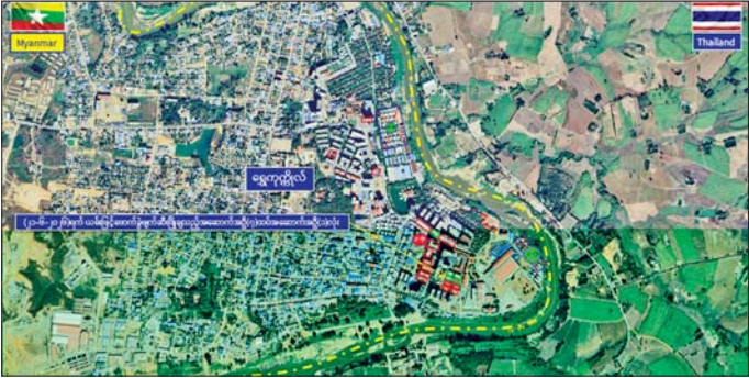
ကရင်ပြည်နယ် မြဝတီမြို့နယ် ရွှေကျိုလ်နယ်မြေရှိ အွန်လိုင်းလိမ်လည်လောင်းကစားမှု လုပ်ကိုင်ခဲ့ သည့် တရားမဝင်အဆောက်အအုံအား ဖောက်ခွဲဖျက်ဆီးမှု။
